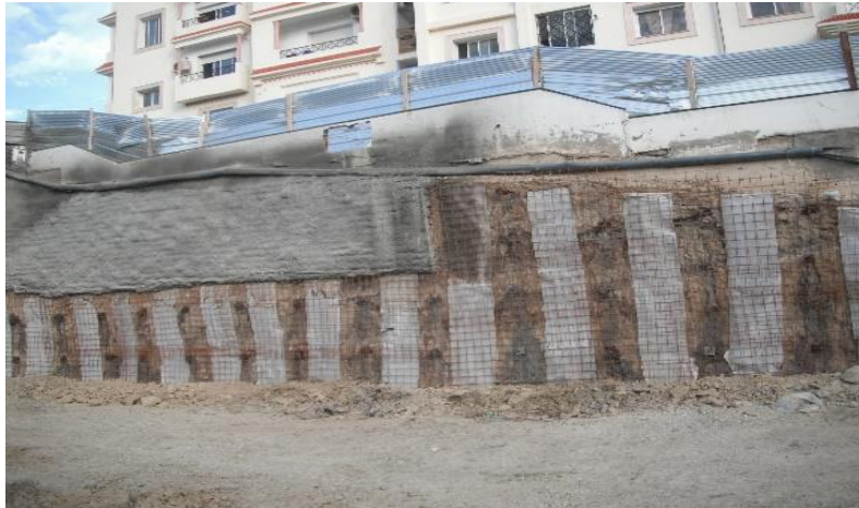
Figure 3. Vue d'ensemble de l'exécution du système de soutènement
